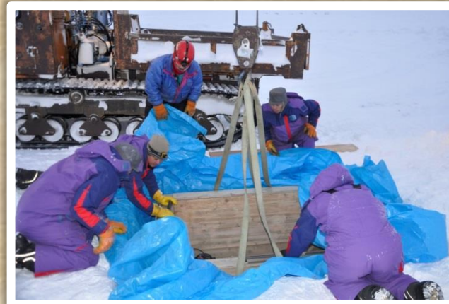
露天風呂設置作業中…
